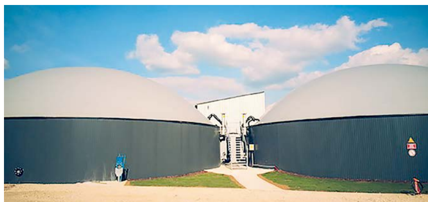
Digesteur et post-digesteur d'une unité de méthanisation.
